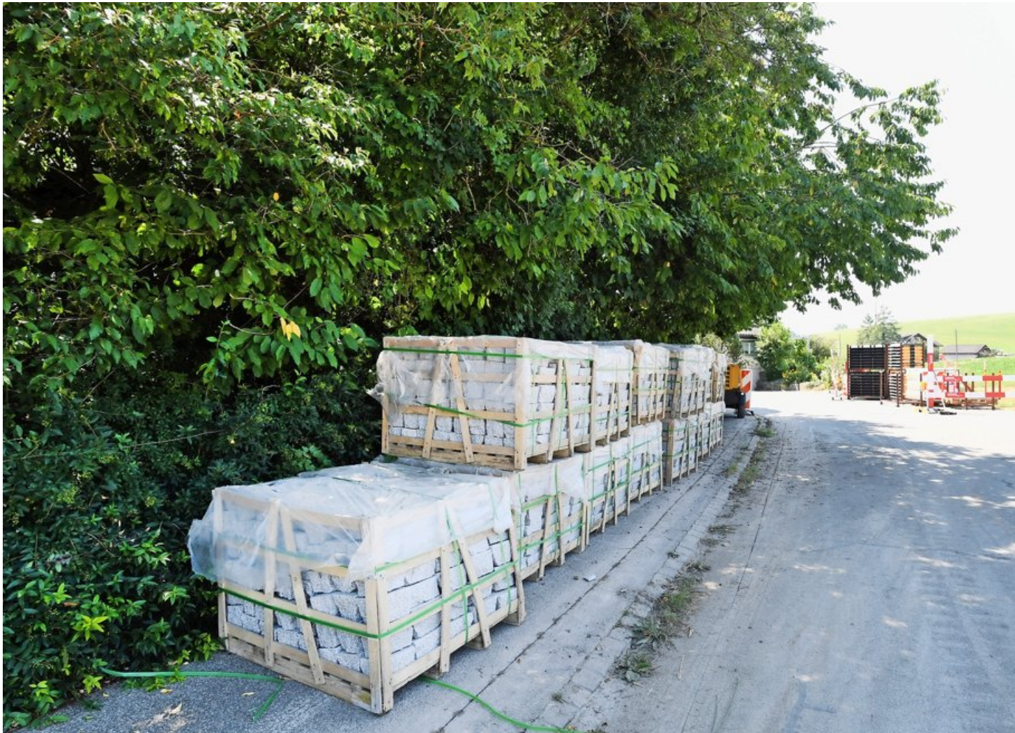
Die neuen Randsteine fürs Trottoir lagern vor Ort – unter viel Grün. Der Bereich der alten, zu ersetzenden Steine ist bereits herausgefräst. Foto: Madeleine Schoder
