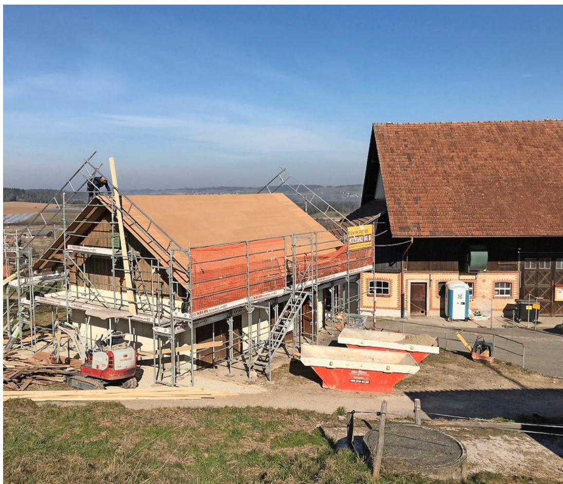
In der Garage gegenüber dem Gundetswiler Bauernhof hat der Umbau begonnen. Foto: PD
