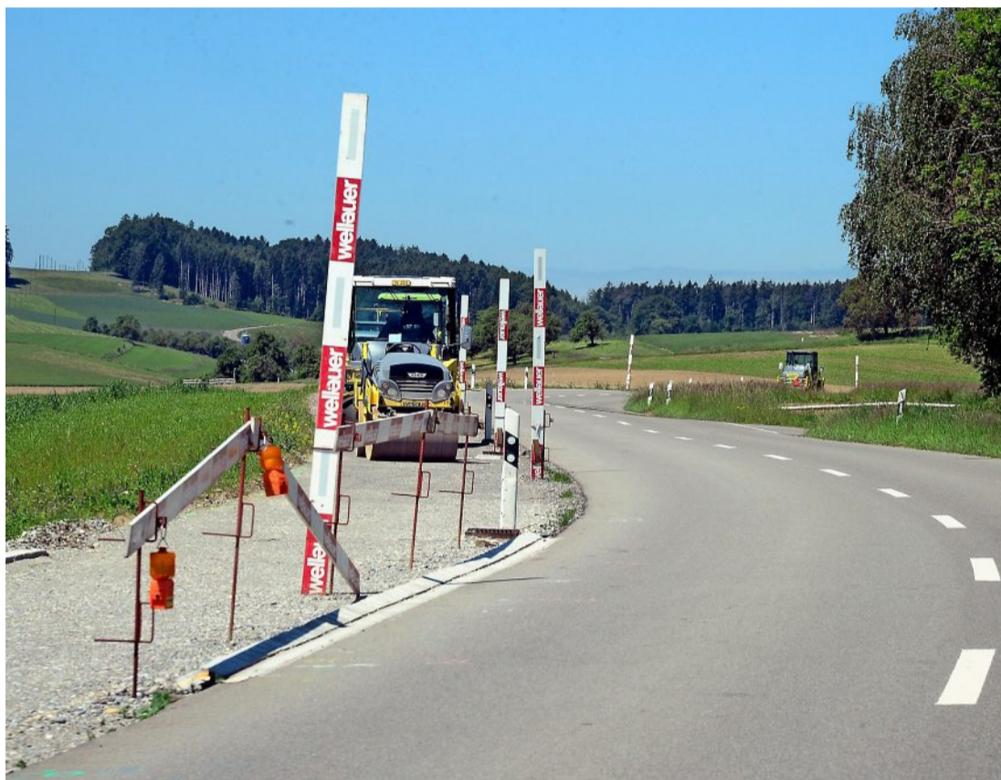
Das Wetter ist besser, aber das Fundament noch nicht trocken genug. Foto: Marc Dahinden
