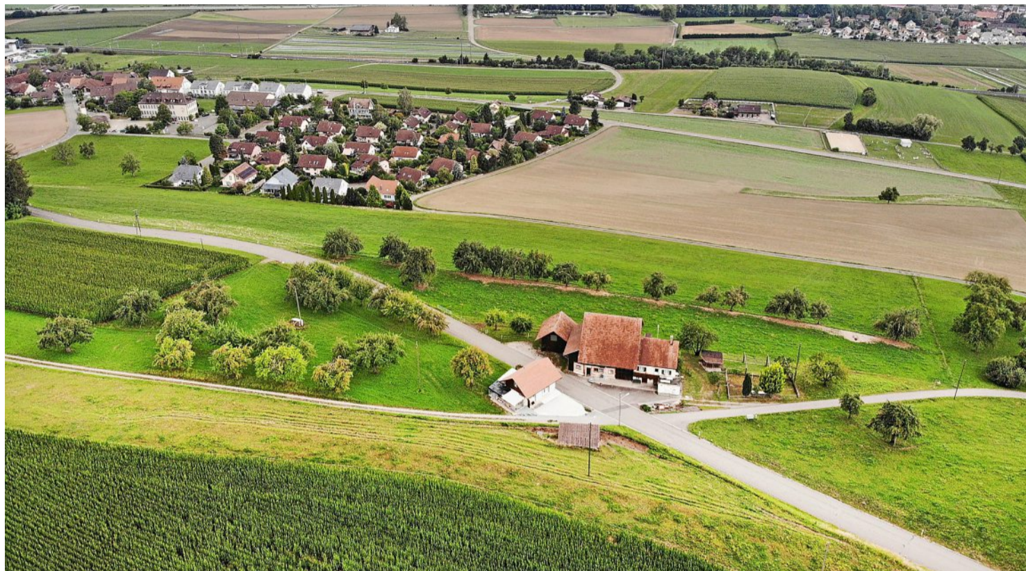
Blick auf das Bauernhaus, aus dem ein Tierheim hätte entstehen sollen. Im Hintergrund das Gundetswiler Wohnquartier. Foto: Madeleine Schoder
